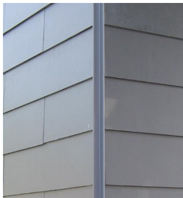
Foto 2: Voorbeeld van een afwerking van een buitenhoek
