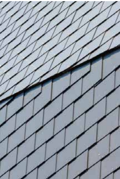
Plaatsing enkelvoudige horizontale dekking of Zwitserse dekking (pijl bovenaan geeft de over-heersende windrichting aan, pijl onderaan de plaatsingsrichting)
