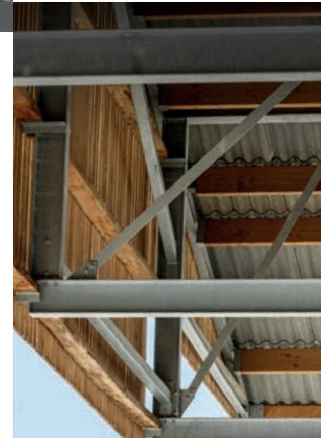
Buiten de loods is geen isolatie nodig en zijn de golfplaten en de gording dus zichtbaar.
